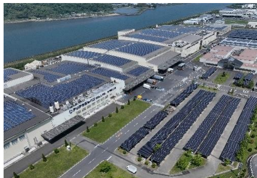
PV導入事例
