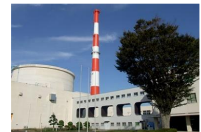
高速実験炉「常陽」
