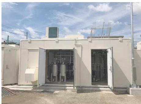
神戸製鋼グループ内の環境事業を担っており、上下水道・産業用の水処理装置の製造・販売、ガス化溶融炉などのごみ焼却プラント、冷却塔、高純度水素発生装置などを手がけています。水素事業では固体高分子電解質膜（PEM）を用いて水道水から高純度の水素ガスをオンサイトで供給する水電解式高純度水素発生装置（HHOG：High-purity Hydrogen Oxygen Generator）を提供しており、コンパクトタイプやスキッドマウントタイプを取り揃えており、様々な分野での納入実績があります。
