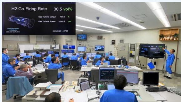
▲水素30%混焼運転実施中の中央制御室
