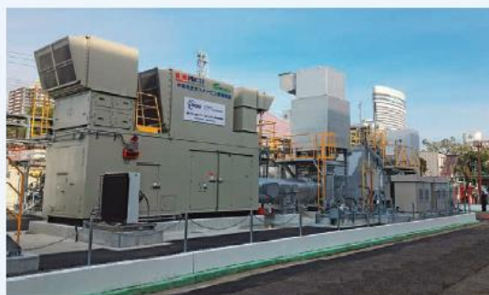
▲水素ガスタービンコージェネレーションシステム（神戸ポートアイランド） NEDO実証事業： 「水素CGS活用スマートコミュニティ技術開発事業」（2015～2018年度） 「ドライ低NOx水素専焼ガスタービン技術開発・実証事業」（2019～2020年度）
