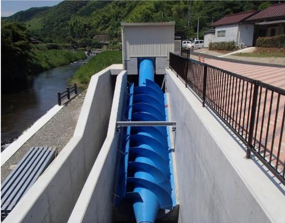
低落差で高効率な発電が可能なのはもちろんのこと、水車構造が単純で塵芥や土砂流入に強く、魚類が流下できるため環境に配慮している。枯葉や刈草などのゴミが詰まりにくい特徴から、農業用水路を活用した小水力発電所に向くとされる。また、流量変動に対しても効率の低下が少なく、最高効率も80%以上ある。
